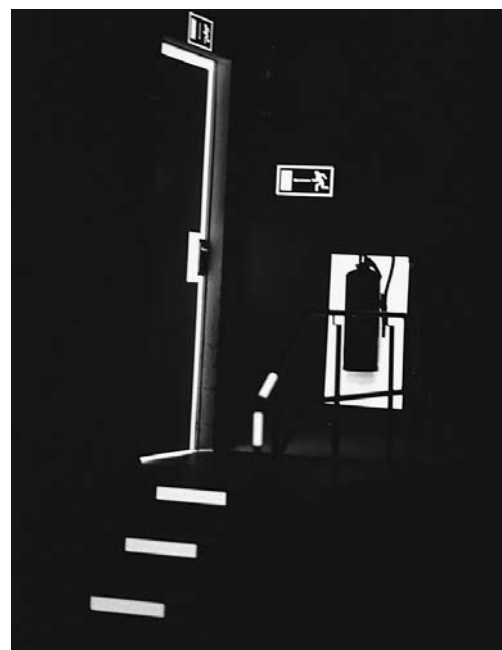
Bild 5: Beispiel einer Kennzeichnung mit Leuchtbändern (Situation bei Dunkelheit)
