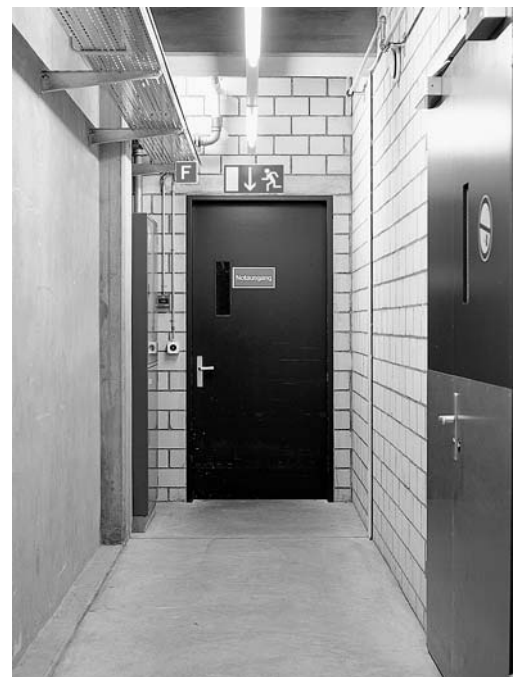
Bild 3: Fluchtweg mit Türe, die sich in Richtung des Fluchtweges öffnen lässt
